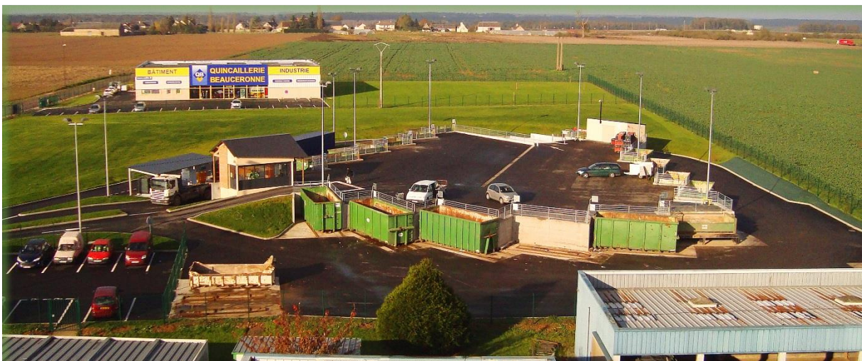
Illustration n°4 : Nouvelle déchetterie de Châteaudun
